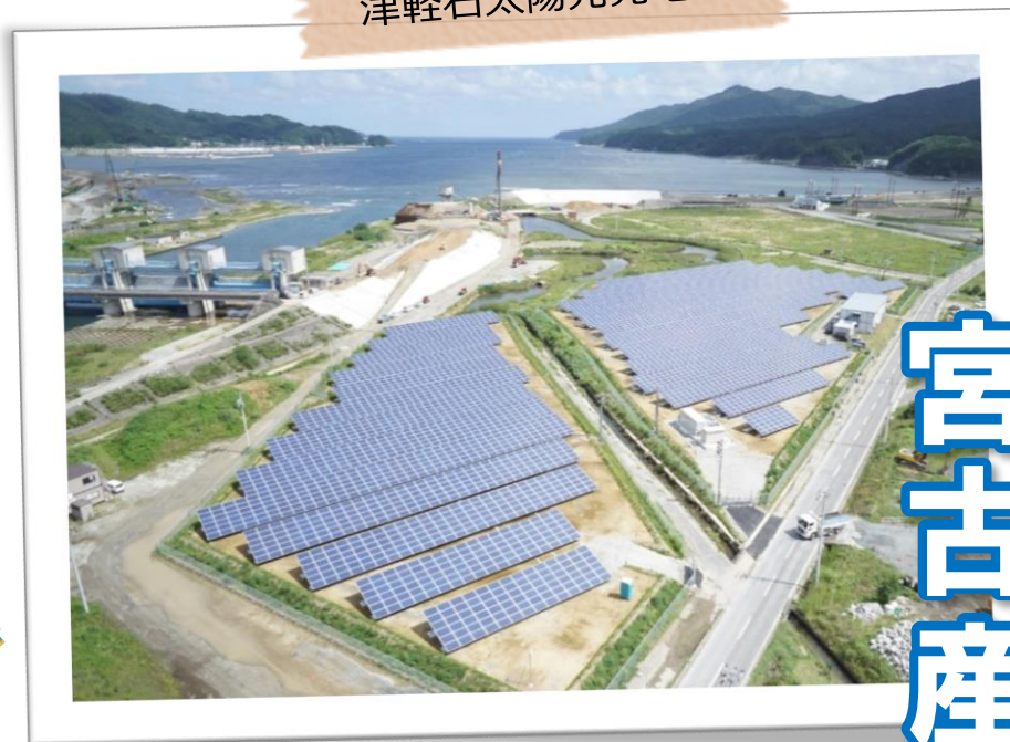
津軽石太陽光発電所
